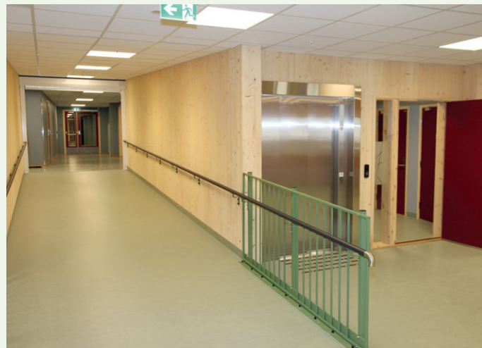
Massivtre gir et solid inntrykk.
