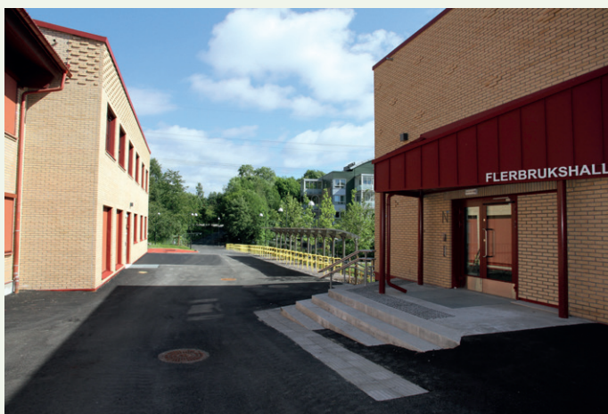
Emma Hjort skole er et prosjekt som består av rehabilitering og nybygg.
