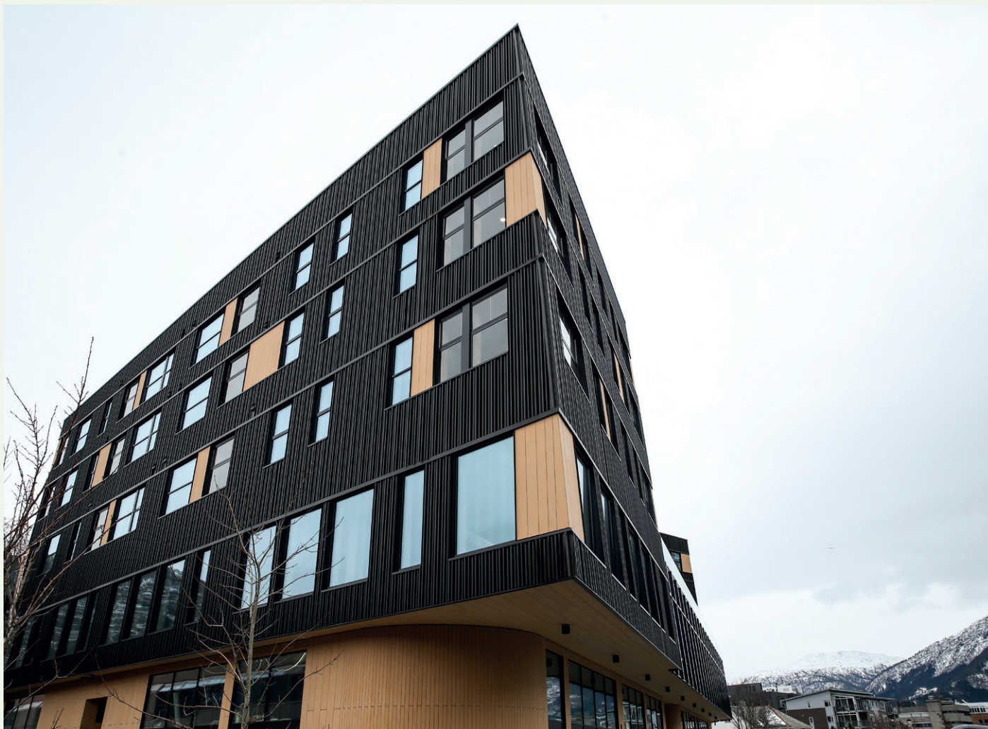
Bygget sett fra sørvest i retning fra elva.
