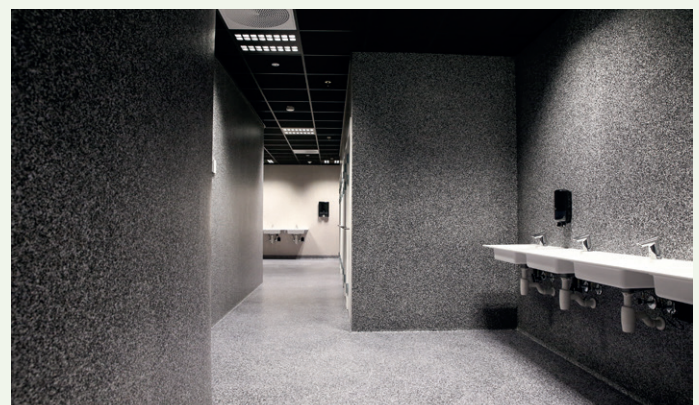
Det felles toalettområdet på gateplan med ti toaletter har dekorativ acrylcon på vegger og gulv.
