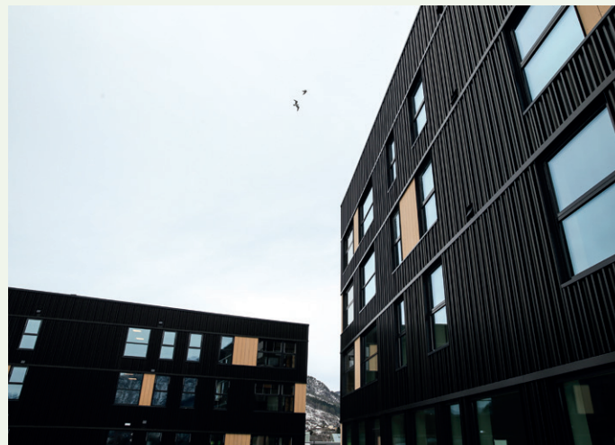
Fasaden har børstede elokserte aluminiumsplater levert av Petal. Dette er et høystandardprodukt som gir fargespill ved ulike værforhold. De er supplert med lys brune Equitone sementbaserte fasadeplater.
