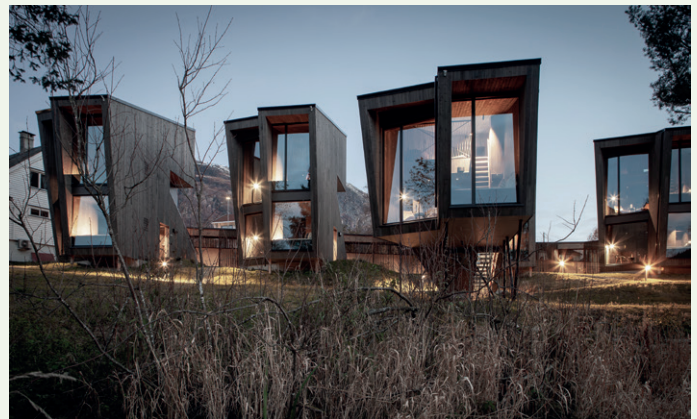
En av utfordringen med bygget er at tomten ligger to til fire meter under flomnivået som er forventet med klimaendringer.
