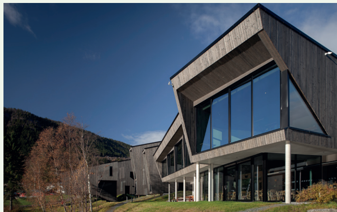
Utbyggingen består av et hovedbygg og fem frittstående tårnhus.
