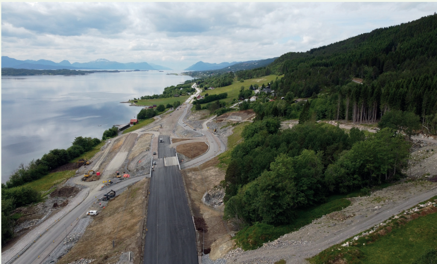
Slutten av veiprojektet mot vest der den nye veien kommer inn på eksisterende vei. Nyanlagt skogsbilvei i skogkanten til høyre. Foto: Statens vegvesen
