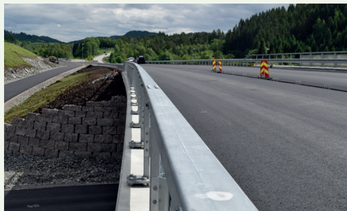
Rett etter denne brua som er den lengste på nyanlegget kommer den nye veien inn på den gamle E39.
