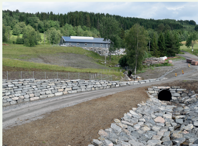
Mange bekkeløp og skråninger langs veien har fått fine natursteinsmurer.
