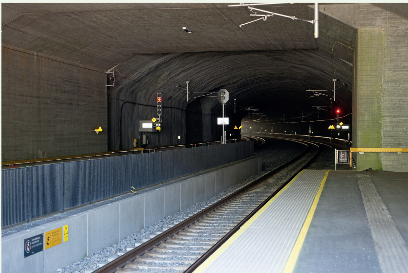
Fra den nye tunnelen på Arna-siden.
