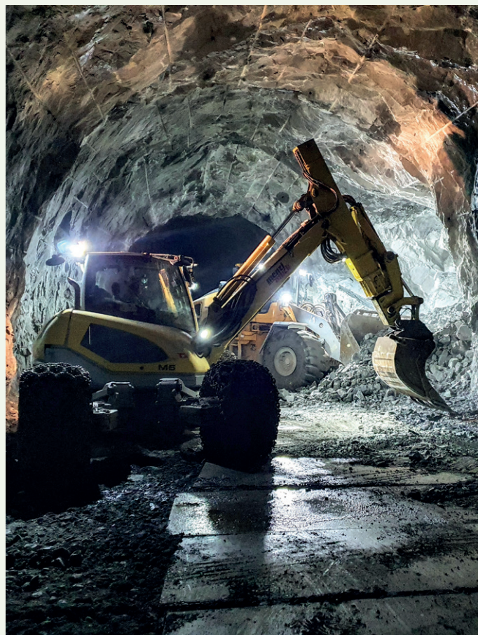
Strossing og lasting av sprengstein i gamle Ulriken tunnel. Sporet ligger beskyttet med plater under arbeidet. Foto Helge Tjelmeland, Bane NOR
