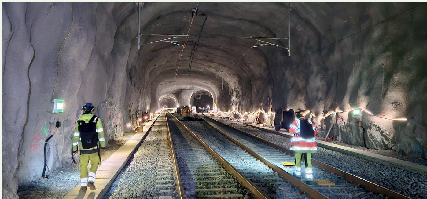
Ferdig rehabilitert gammel tunnel i utvidelsen ved Arna.
