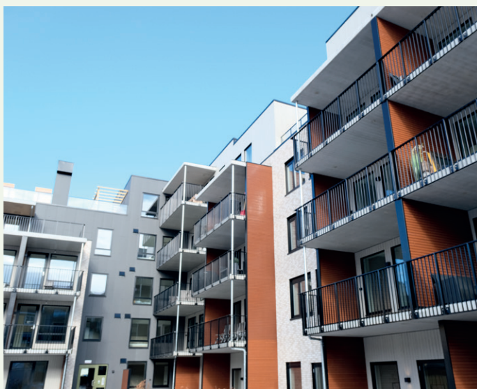
Bygget omkranser en felles bakhage.
