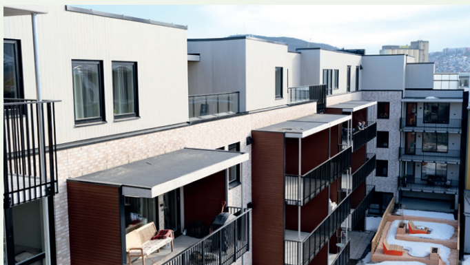
Prosjektet er ferdig seks måneder tidligere enn planlagt, ifølge anleggsleder Stian Barth.
