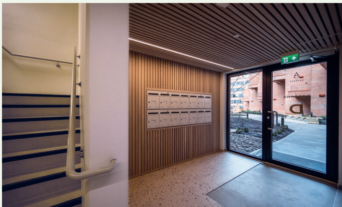
Trespiler på veggene og i taket i fellesarealer demper romlyden. Foto: Skarp
