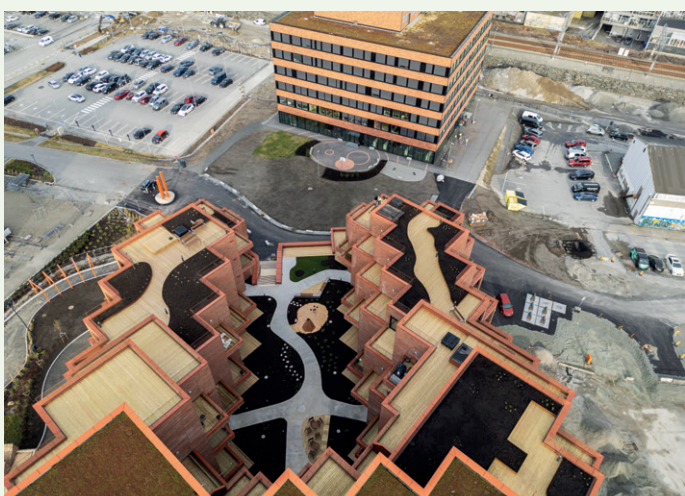
Ankeret har fem felles takterrasser.
