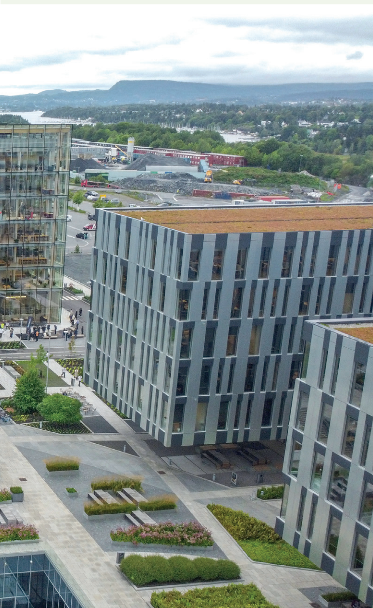
Jernredusert energiglass uten solbeskyttelsesfilm eller solavskjerming er brukt til fasaden.
