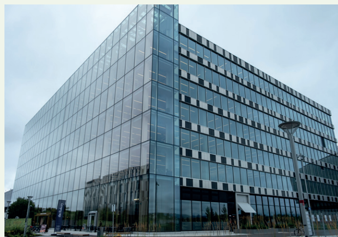
Jernredusert energiglass uten solbeskyttelsesfilm eller solavskjerming er brukt til fasaden.
